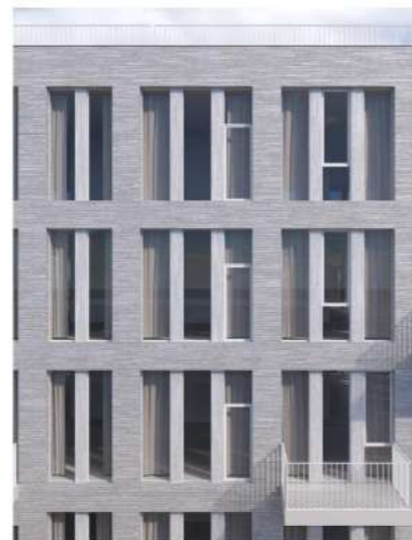
détail façade lot 3
