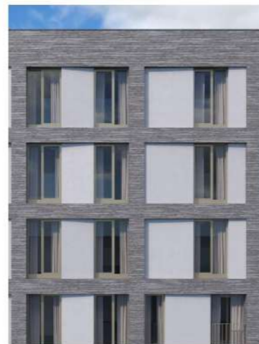
détail façade lot 2
